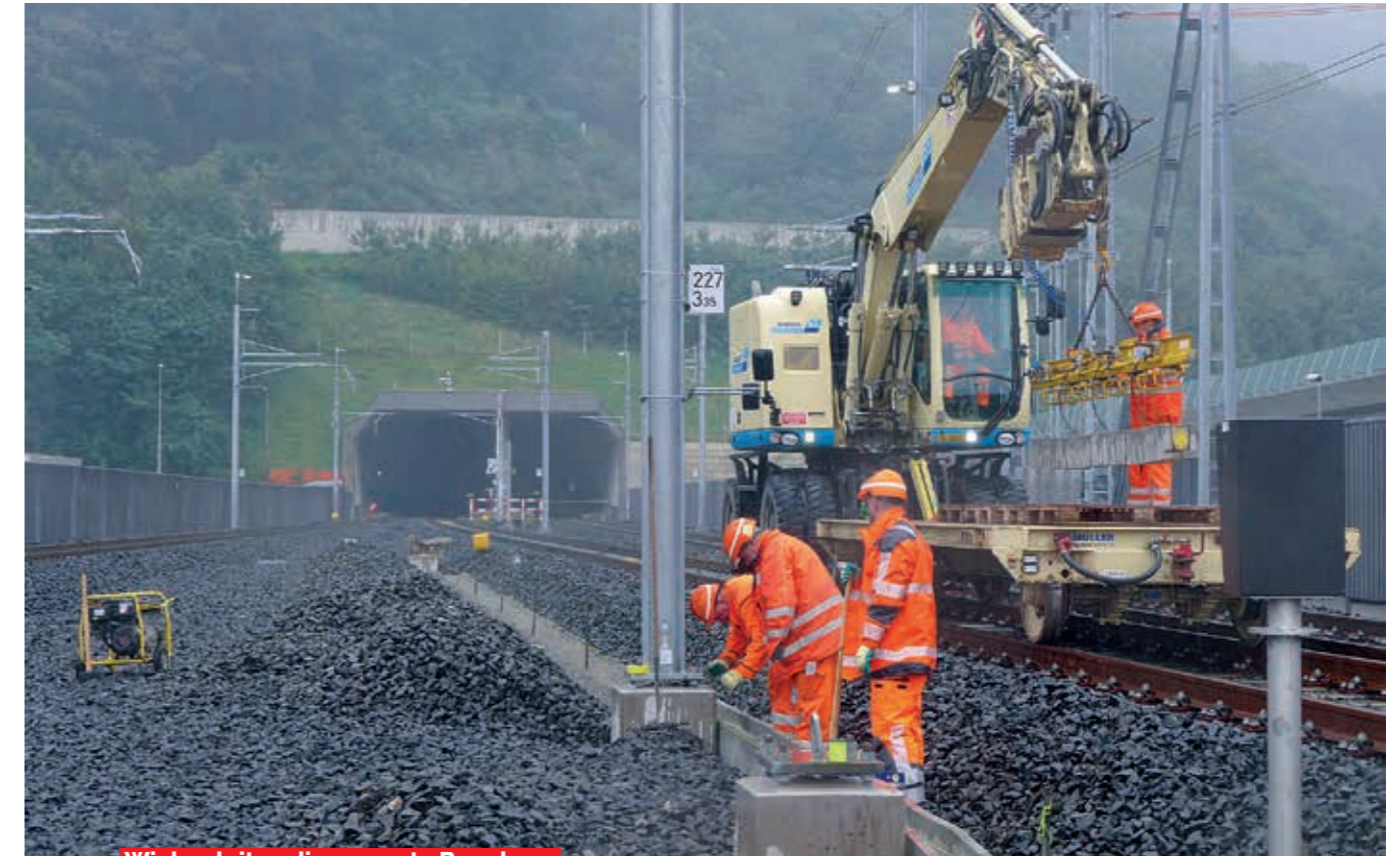
Wir begleiten die gesamte Bauphase
