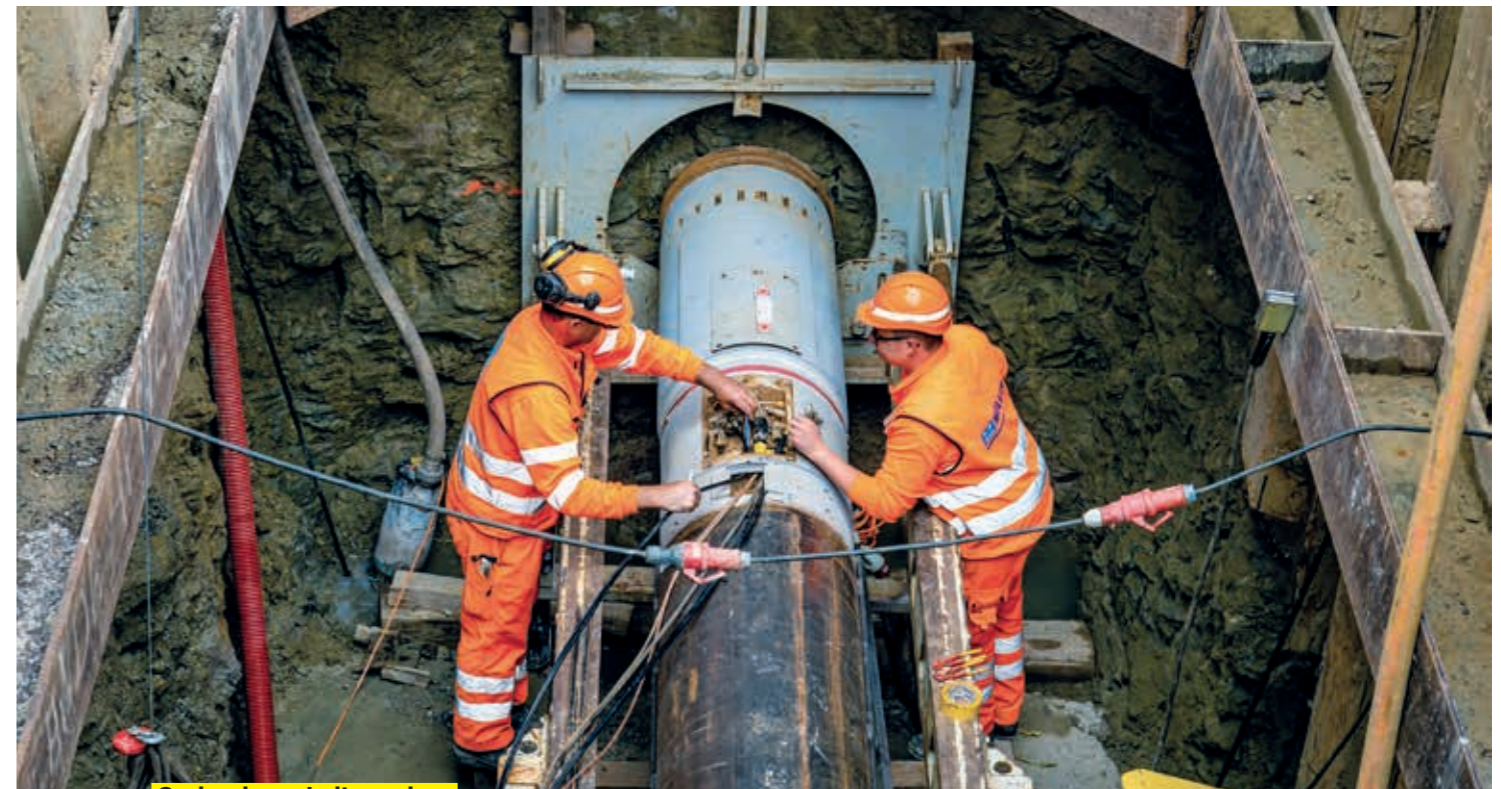
Grabenloser Leitungsbau
